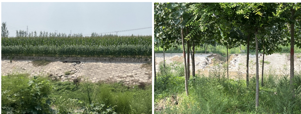
图2.2-4 桩号19+180~71+890段渠道护砌损坏现状图
